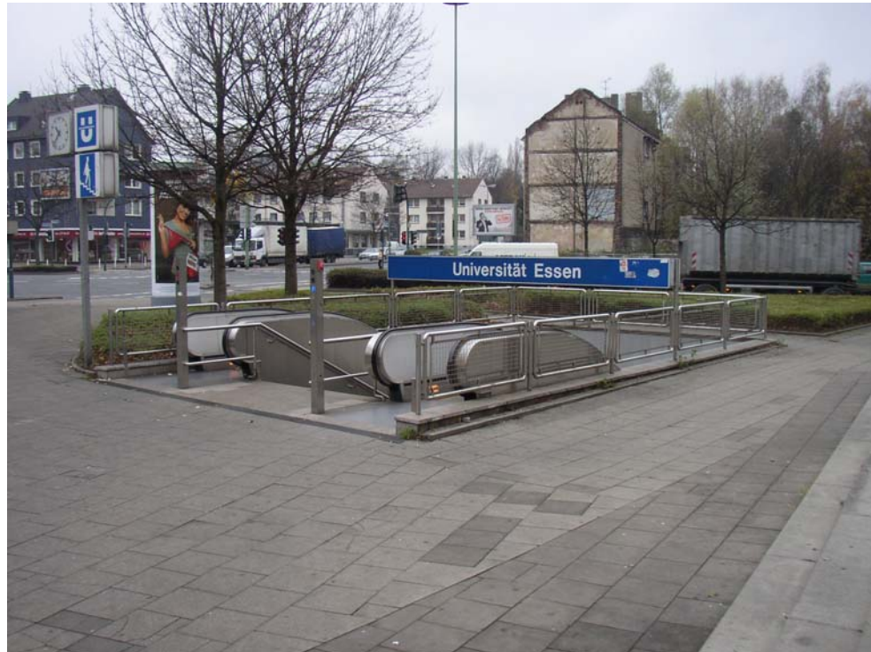
■ Abbildung 16: Zugang zum U-Bahnhof Universität Essen
