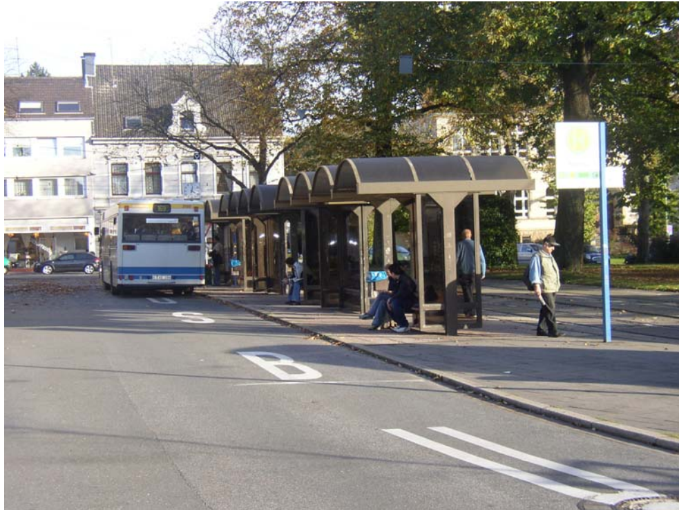
■ Abbildung 37: Verknüpfungspunkt Bredeneu: Bus-Haltestellen ohne niederflurgerechten Ausbau
