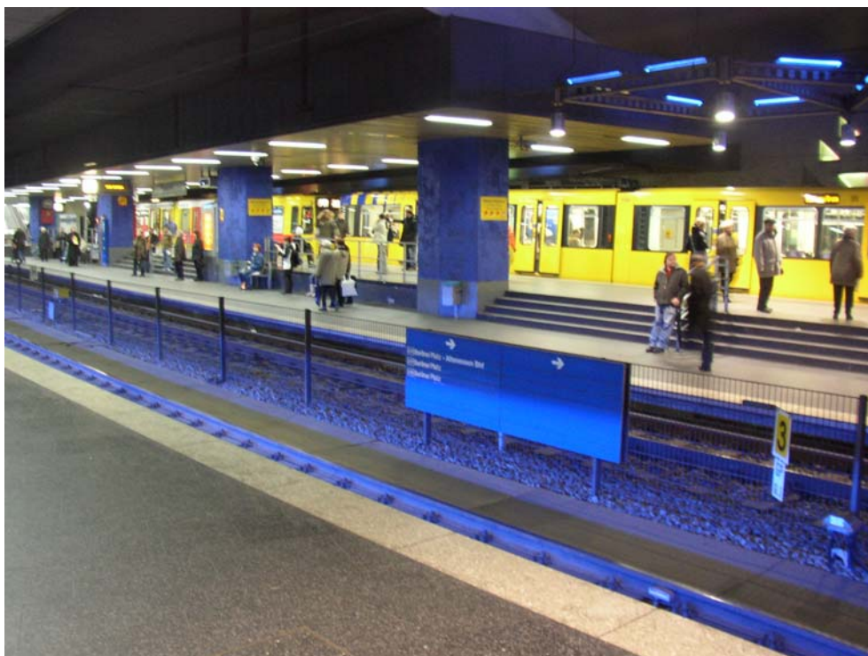
■ Abbildung 6: U-Bahnhof Hauptbahnhof („-2-Ebene“)
