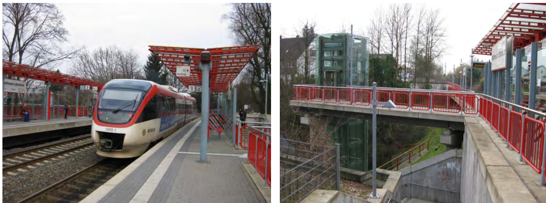
Abbildung 15: SPNV-Zugangsstelle Mettmann Zentrum
