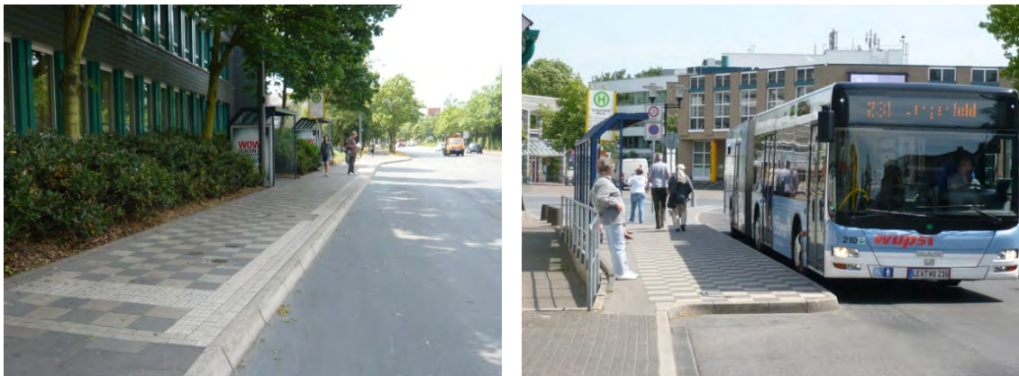
Abbildung 13: Innenstadthaltestellen Langenfeld Rathaus und Langenfeld Marktplatz
